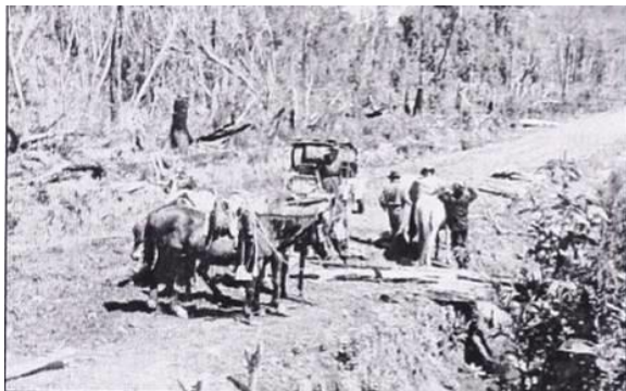
Construcción de camino El Amarillo, año 1943
